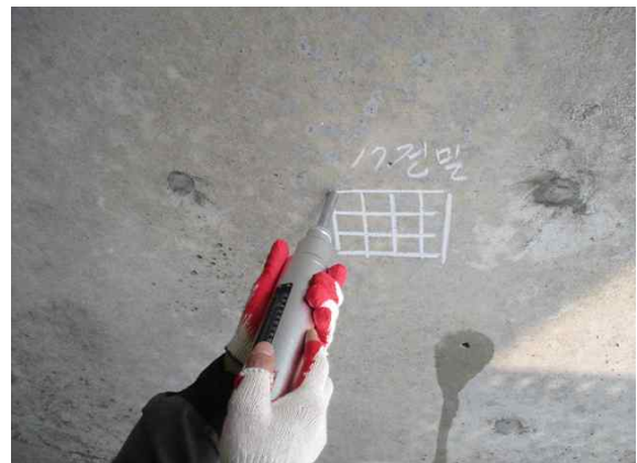
반발경도 측정 현황(측벽부)②
