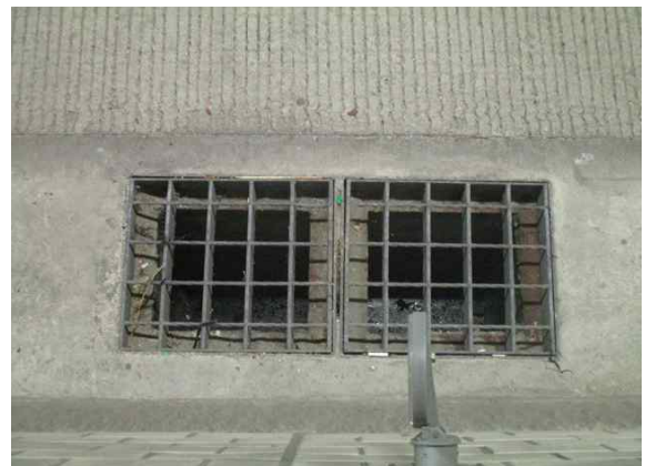
배수시설 집수구 상태양호
