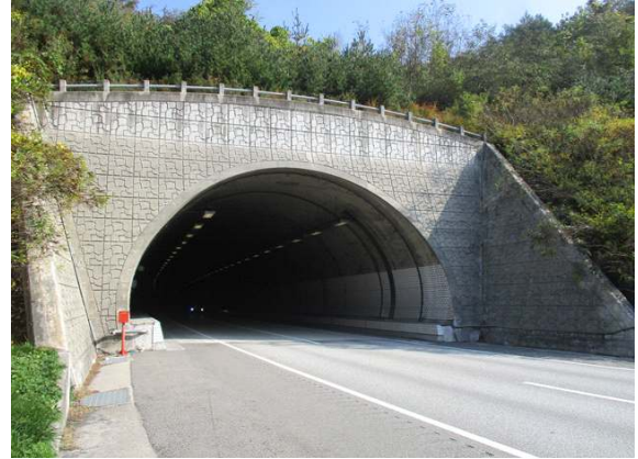
시점부 옹벽 상태양호
