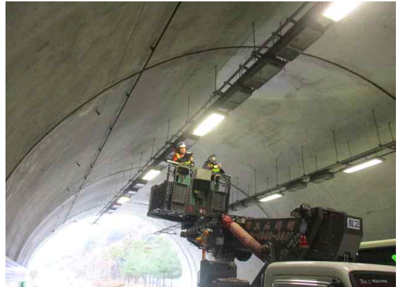
고소작업차를 이용한 외관조사 현황②
