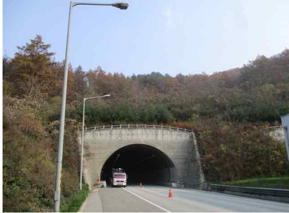
시점부 옹벽 전경
