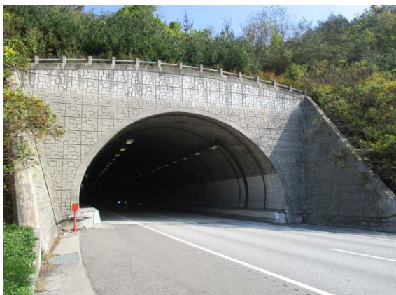
시점부 갯문 전경
