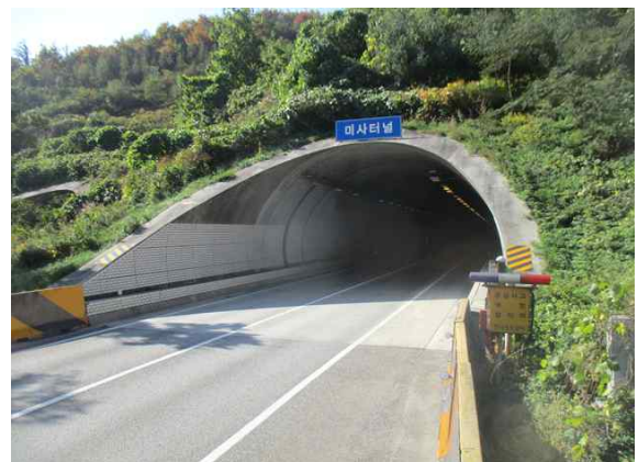
종점부 갯문 전경
