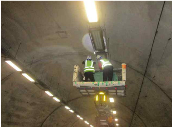
고소작업차를 이용한 외관조사 현황①
