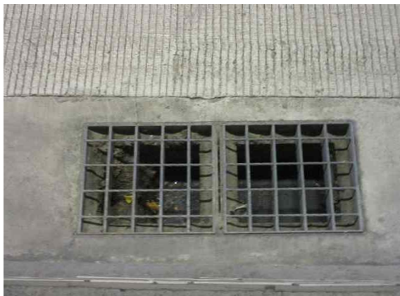
배수시설 집수구 전경
